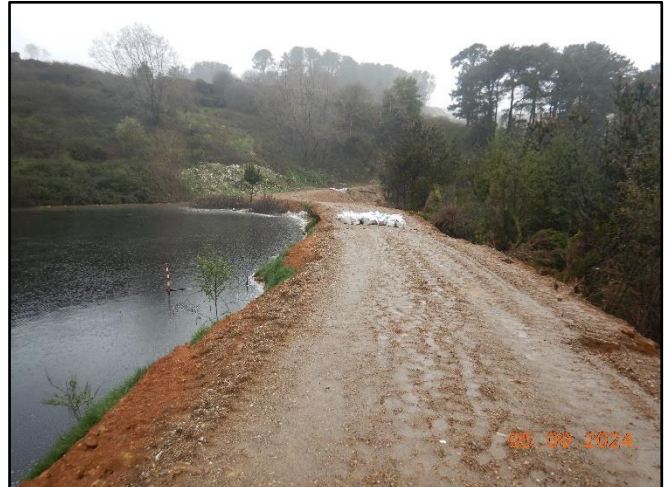
Fotografía 2. Coordenadas UTM DATUM WGS84 18S Descripción del medio de prueba: Peralte del talud sur (un metro de altura aproximado) con maicillo, con el fin de reforzar el talud sur de la laguna de lixiviados. Al fondo se aprecia acopio de sacos con material terreo, lo que han sido incorporados también ladera sur por el interior de la laguna.
